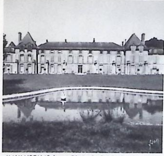
MALMAISON (Seine-et-Oise) - Le Palais, façade ouest.
