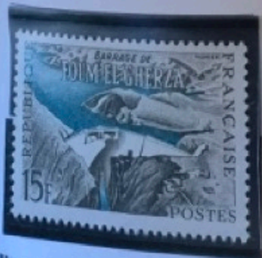
Barrage de Foug el Gherza.
