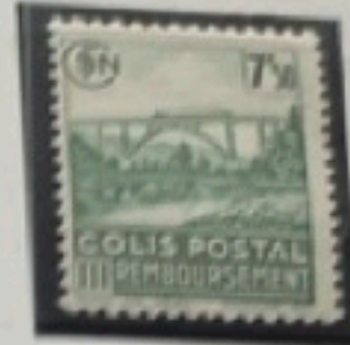
Viaduc de Garabit
