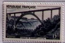
Viaduc de Garabit.
