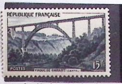
Le Viaduc de Garabit
