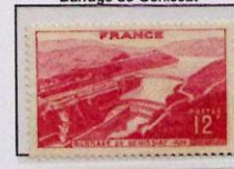
Barrage de Génissat
