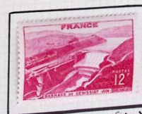
Barrage de Génissiat
