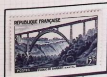
Viaduc de Garabit
