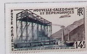
Transbordeur de Minéral de Nickel
