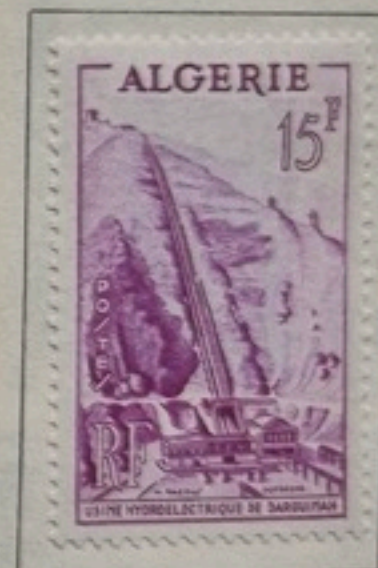
Usine Hydroélectrique de Darguinah
